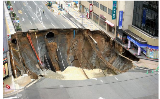
事故から1年以上経って、ようやく工事再開の目途が立とうとしています。
